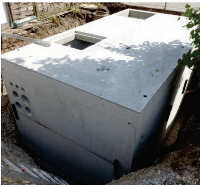
Technischsacht aus 2 monolithischen Schalen, die mit Dichtband wasserdicht verbunden sind
