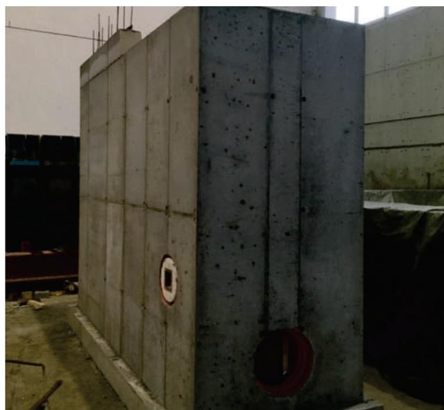
Maßanfertigung mit einer Systemschalung in druckwasserdichter Ausführung
