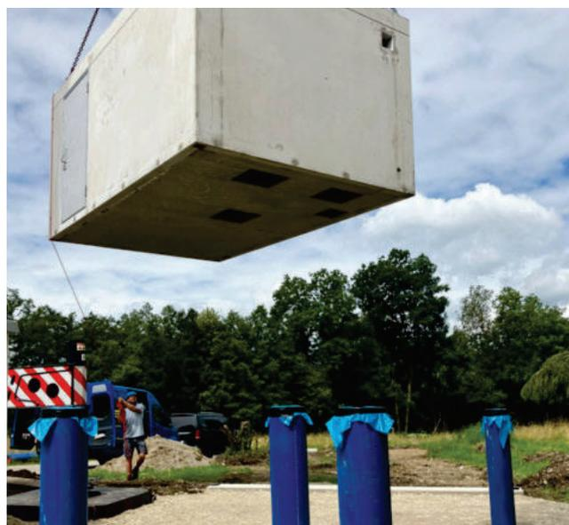
Betonfertigteilbauwerk für die Wasserversorgung
