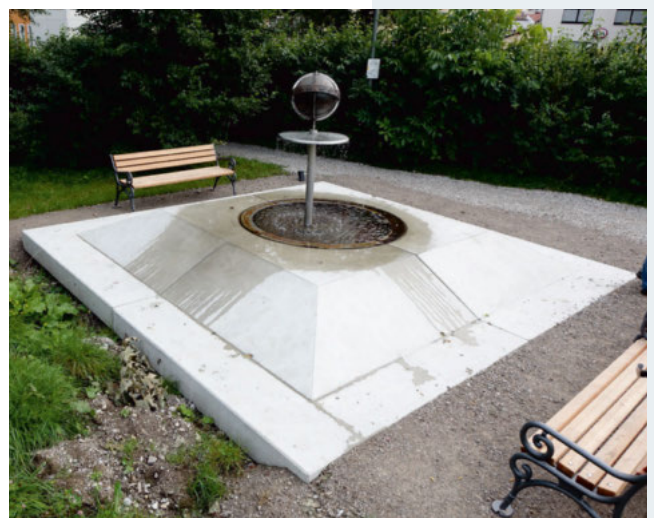
Brunnen in Sichtbeton
