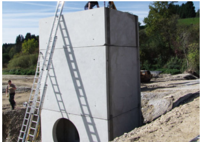
Auslaufbauwerk in Bad Endorf
