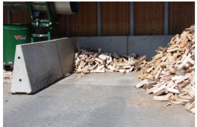
Trennwände zur Lagerung von Holzscheiten
