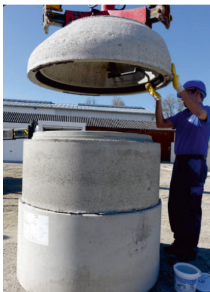
IDLA-Schachthals mit Gleitmittel versehen.....
