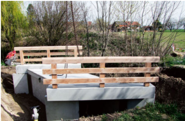
Spannweite 192 cm, Fahrbahnbreite 350 cm
