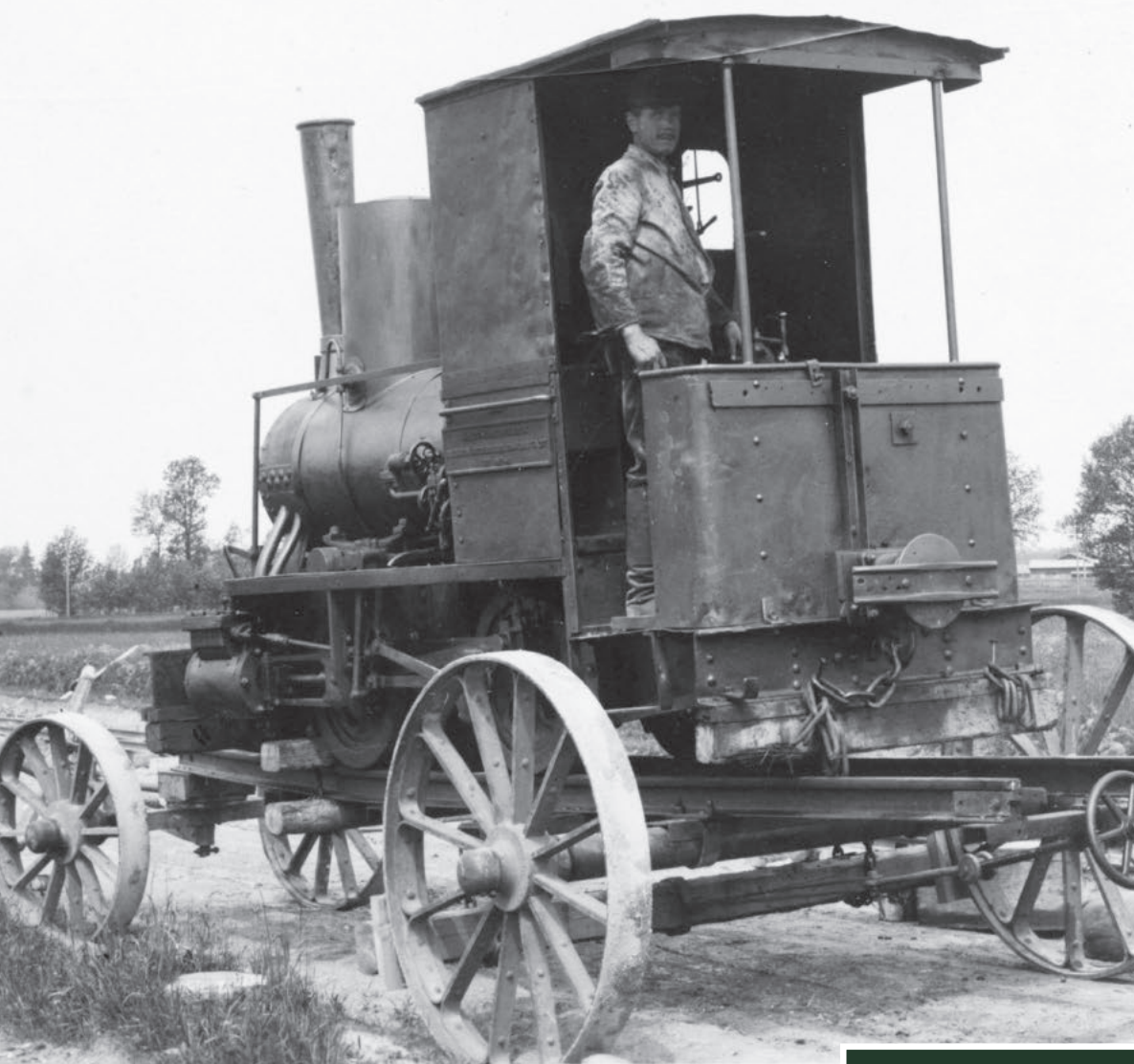
LOKOMOTIV TRANSPORTWAGEN Z. KANALBAU D. ELEKTWERK ROSEN
