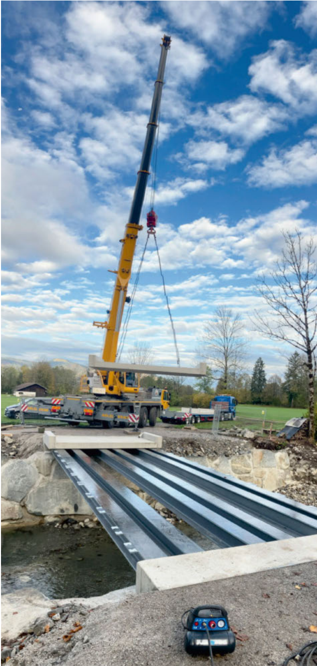
Oberbau aus 6 Fertigteilelementen
