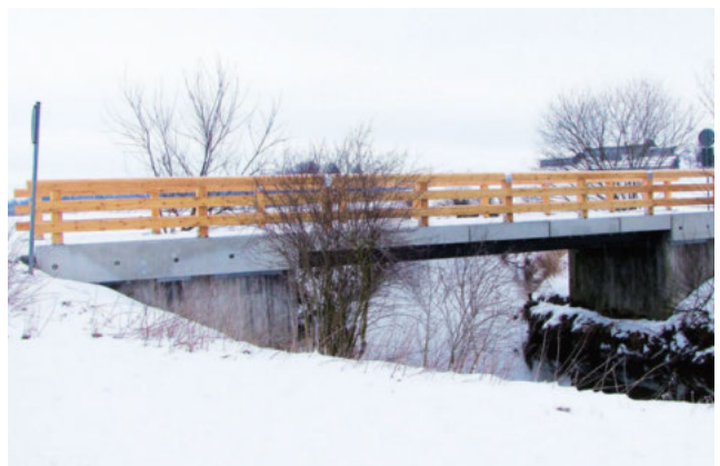
83043 Bad Aibling, Glonnbrücke bei Holzhausen
