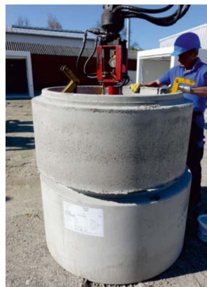
Ring aufsetzen.... (auf vertikale Anordnung der Lastübertragungselemente achten!)
