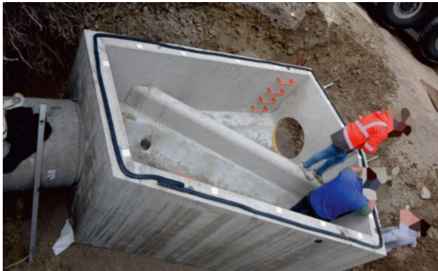
Trennbauwerk in Miesbach
