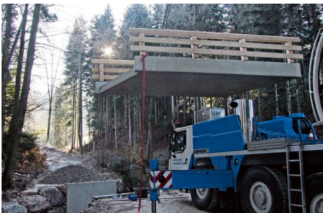
Versetzen der einteiligen Brückenplatte
