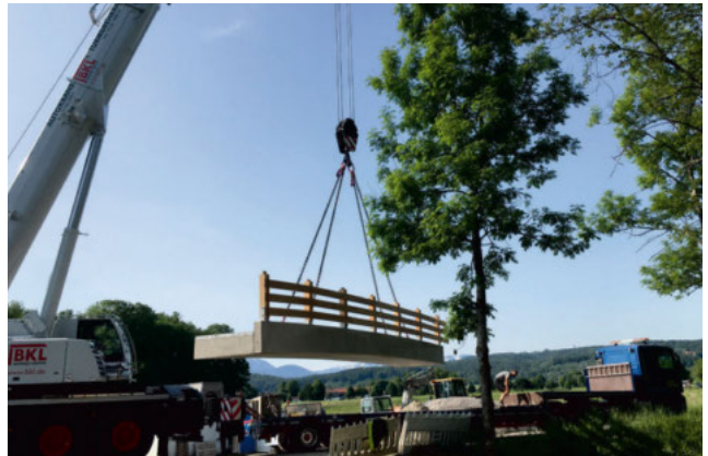
Versetzung mit dem Autokran...
