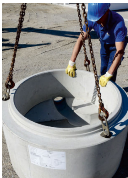
Schachtunterteil setzen.....
