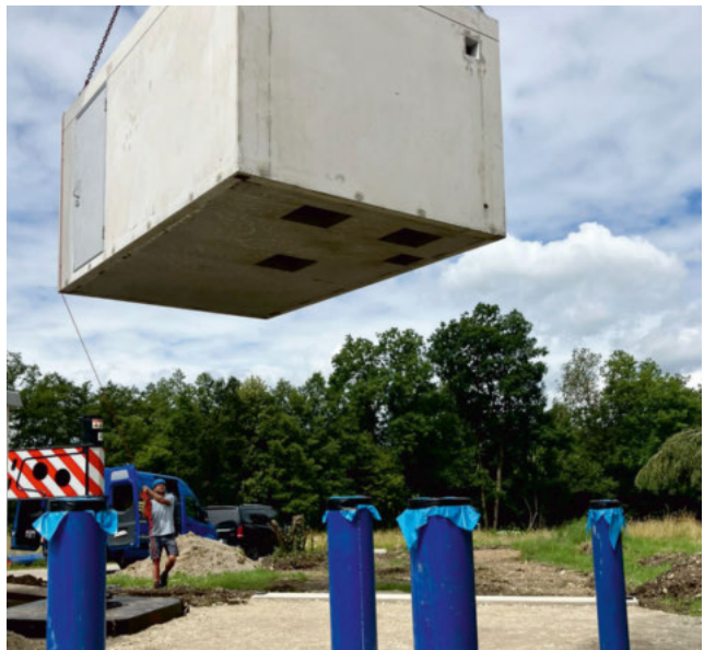
Betonfertigteiltbauwerk für die Wasserversorgung
