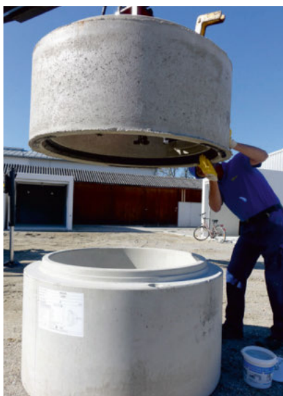
IDLA-Schachtring mit Gleitmittel versehen.....
