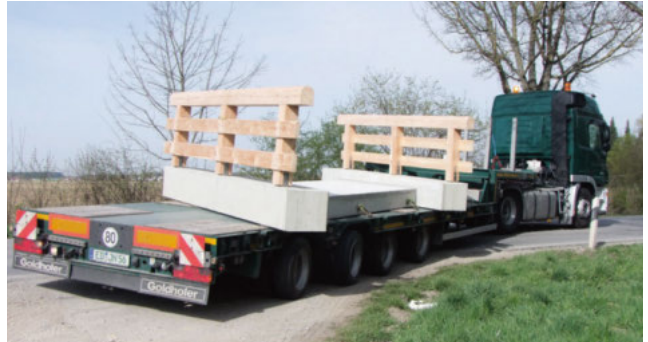
Anlieferung der kompletten Brückenplatte
