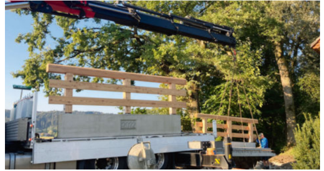
Anlieferung der Brückenplatte
