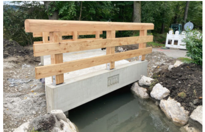
fertig montiertes Geländer in Balkenschuhen
