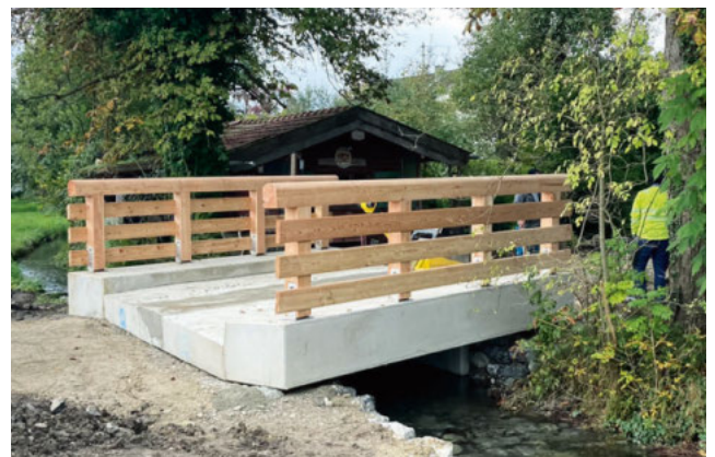
kurze Bauzeit durch Vorfertigung
