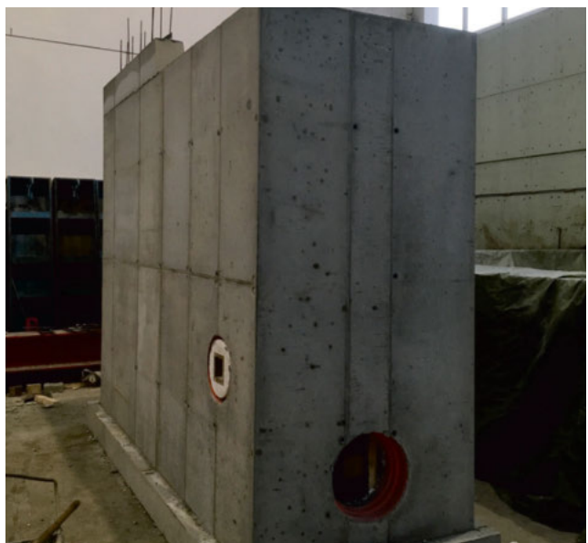
Maßanfertigung mit einer Systemschalung in druckwasserdichter Ausführung
