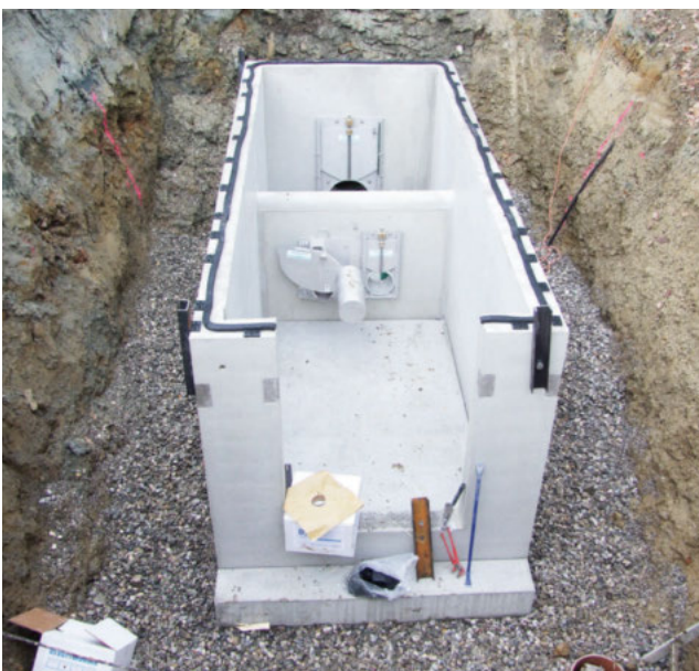
Auslaufbauwerk in Riedering, mit Abflussbegrenzer und Ablaufschieber in Edelstahl
