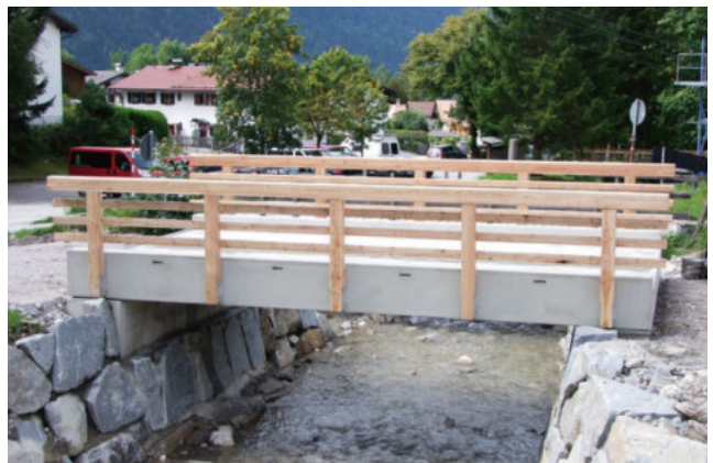
82487 Oberammergau/Brücke über die Große Laine
