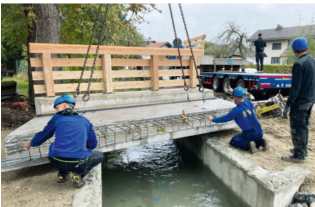
Versetzung auf Mörtelbett für Lastausgleich
