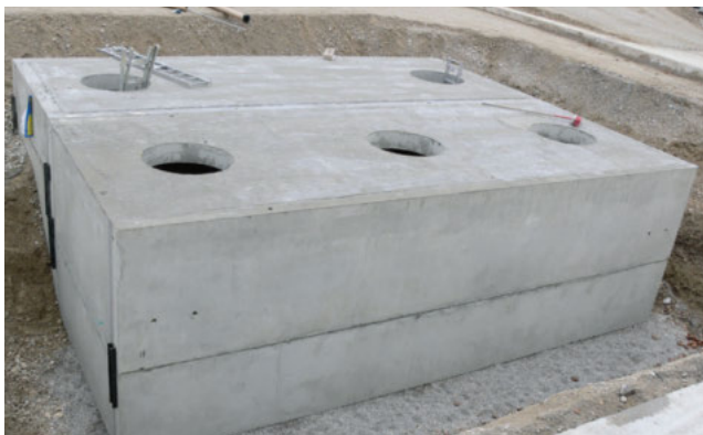
Rigolenanschlussschacht für MAN in München
