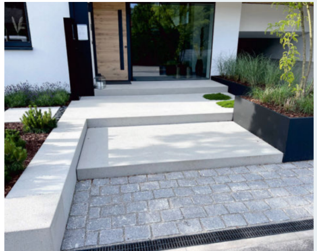
Eingangsbereich mit großen Betonplatten gestrahlt
