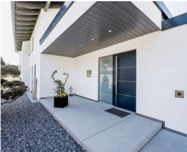
Eingangsbereich mit großen Betonplatten gestrahlt
