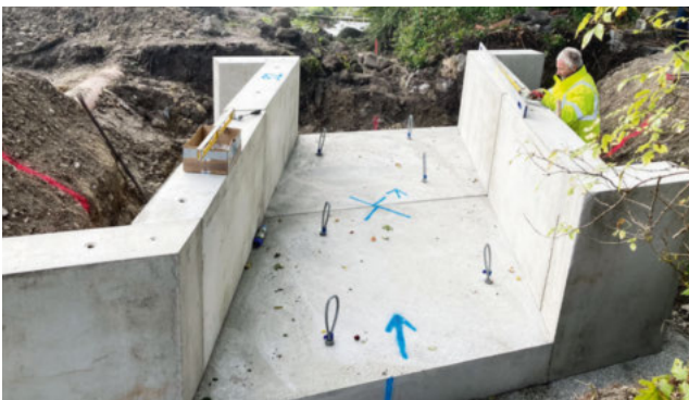
Unterbau in Rinnenausführung
