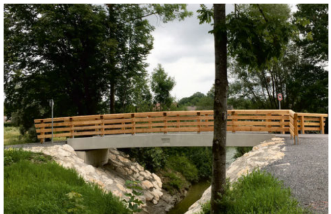
und optisch ansprechendem Lärchengeländer
