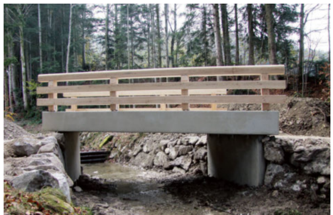
Spannweite 437 cm, Fahrbahnbreite 300 cm, Kreuzungswinkel Bach / Straße 66°
