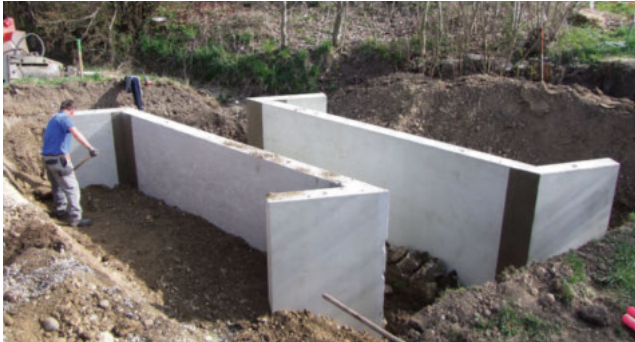
Widerlagerversetzung
