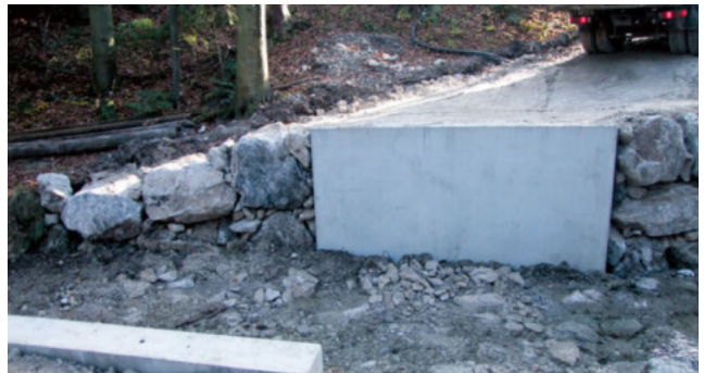
Hinterfüllung der Widerlager, Bachausbau
