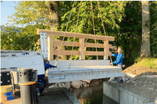
Versetzung mit Autokran oder Kran-LKW
