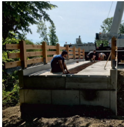
Plattenstoß mit Verschlaufung
