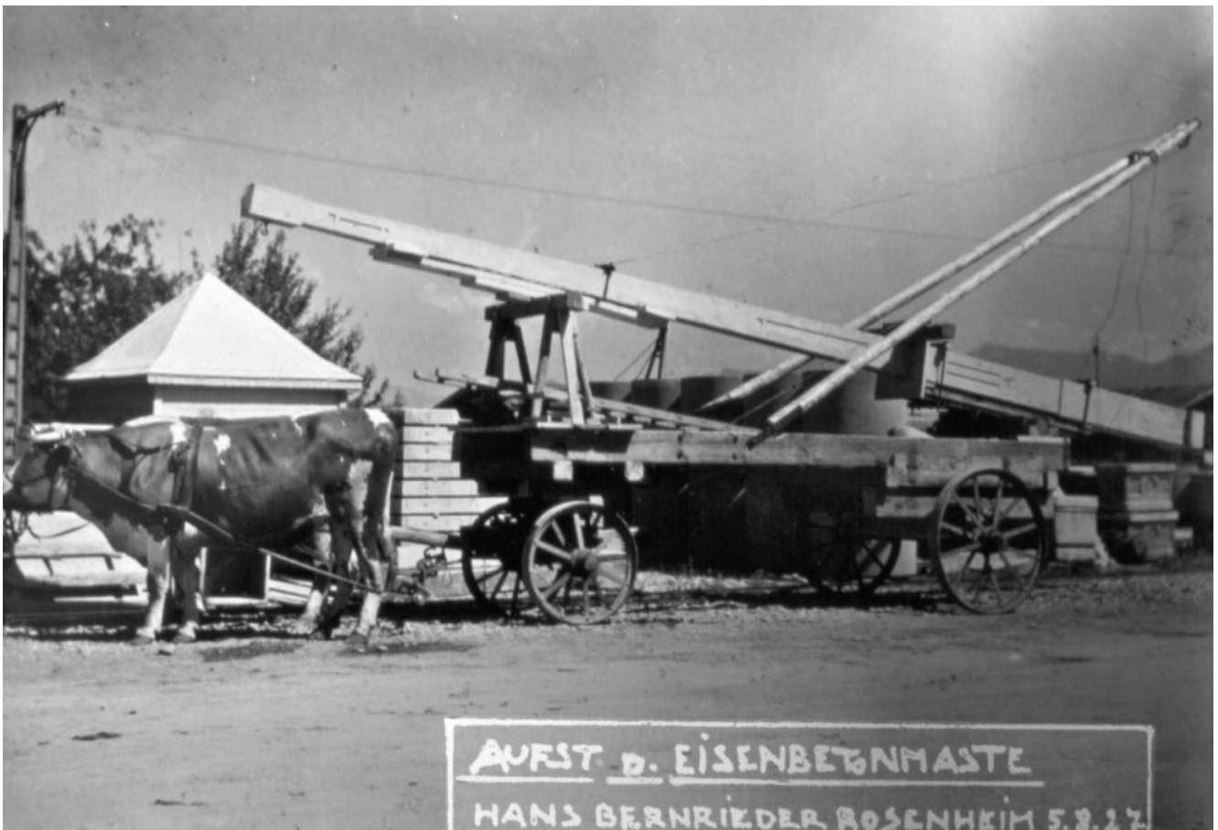
Transport- und Aufstellungswagen mit Ochsengespann für Stahlbetonmasten. 1927
